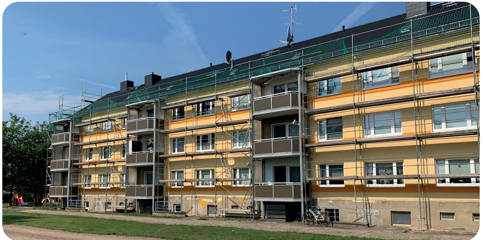
Entstehung der neuen Fassade: Am Mühlenholz 26 bis 28 – Frühjahr 2020
